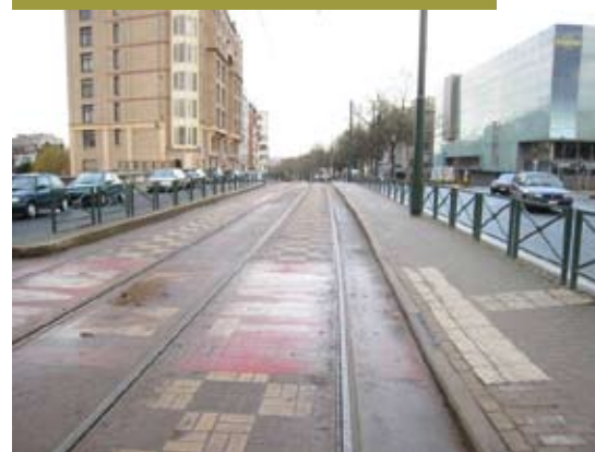
Présence de barrières de sécurité à un arrêt de tram
