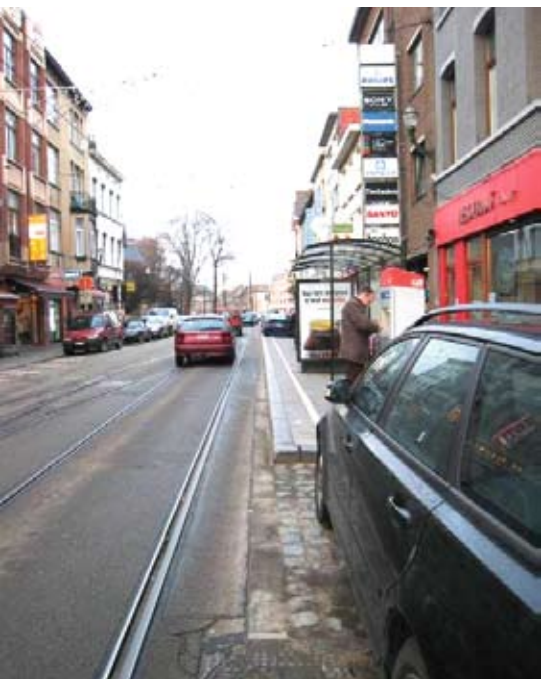
Aménagement d'une avancée de trottoir.
