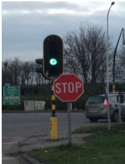
> Het STOP-bord mag aan de verlichtingspaal bevestigd worden.
