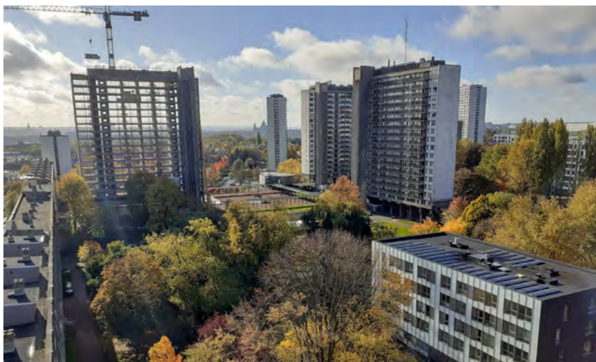
> Cité modèle : rénovation, maître d'ouvrage - Foyer Laekenois
